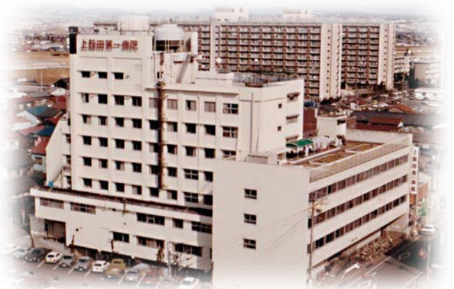
▲昭和48年頃 昭和48年11月…上飯田第一病院(205床)新築移転
